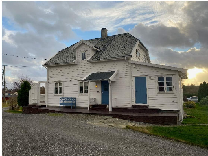
Eksisterende bolig mot sørøst og nordøst
