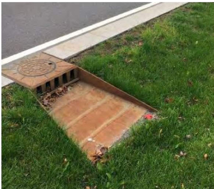
Bilde 1: Kjeftsluk som overfører vegvann til regnbed.
