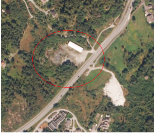
Oversiktsbilde, gbnr 188/5 med rubbhall
