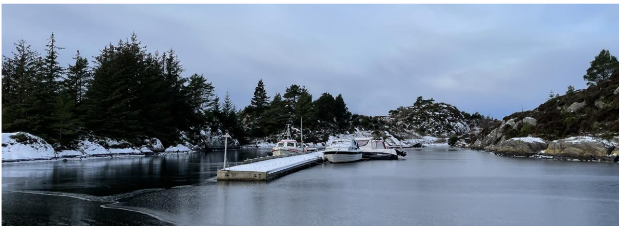
Figur 5-29 Det er plass til å passere med småbåt på nordaustsida av småbåtanlegget. Foto: Multiconsult
