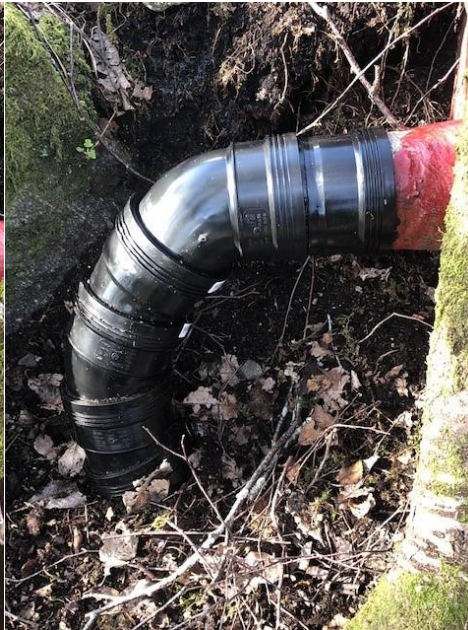
Bilde 2, etter utbedring
