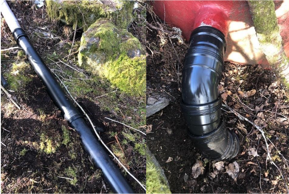
Bilde 1, utbedret brudd avstand.
