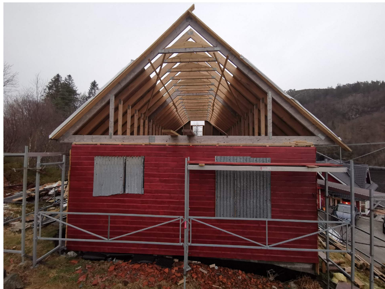
Fasade sør med PÅBEGYNT rehabilitering. Har dessverre ikkje bilde før det.
