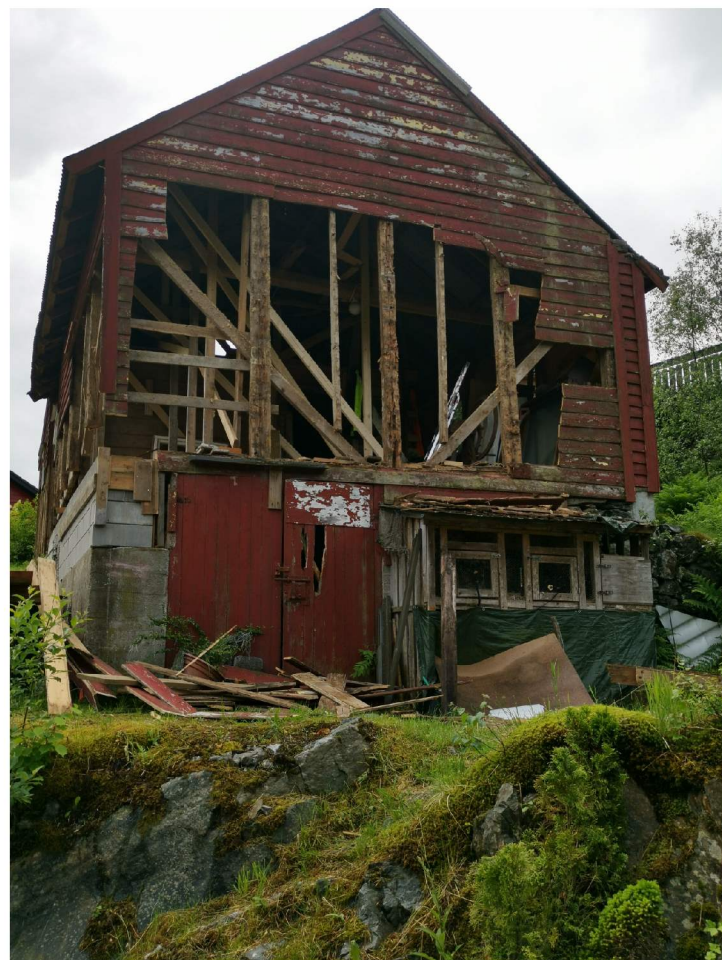
Fasade nord FØR rehabilitering
