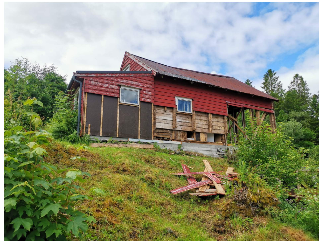
Fasade øst FØR rehabilitering
