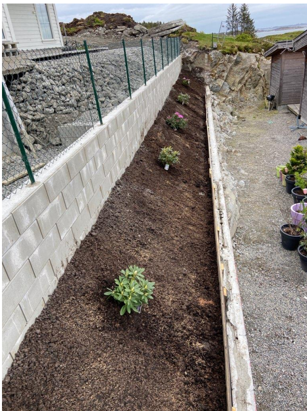
Bildet viser at omsøkt prosjekt er ferdigstilt, og at det er etablert fallsikring på toppen.
