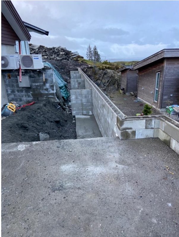
På dette bildet er den nye muren gjort klar for støping.
