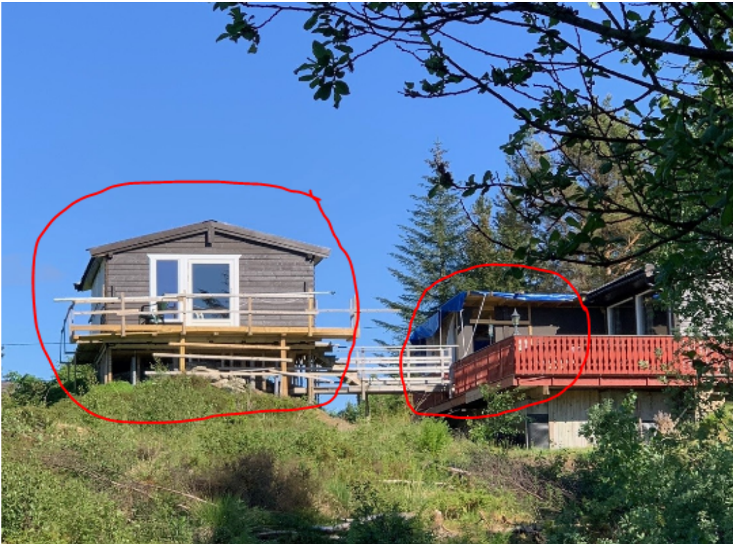
Søknadspliktig og dermed ulovleg oppført bygning og tilbygg på eigedommen
