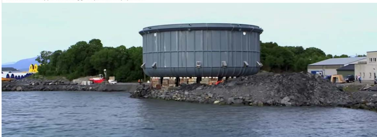
Tankvolum 21000 m 3 . 4 pumper med kapasitet 100 m 3 pr. min. (samla 24000 m 3 pr. time) .
