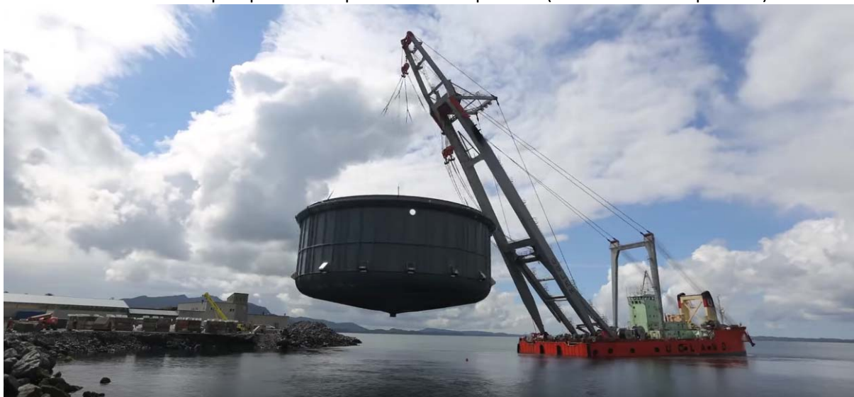
Tankvolum 21000 m 3 . 4 pumper med kapasitet 100 m 3 pr. min. (samla 24000 m 3 pr. time) .
