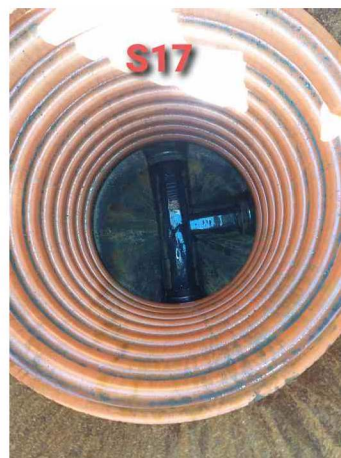
_S17_S16_30062022_012629_018.jpg, 00:00:00, 0.00 Start inspeksjon, 0% / Fra S17. Meterkum, åpen profil
