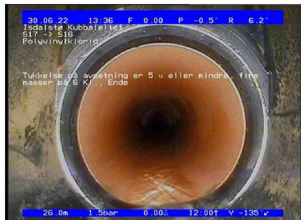
_S17_S16_30062022_012629_008.jpg, 00:05:48, 26.04 Tykkelse på avsetning er 5 % eller mindre, fine masser på 6 Kl., Ende / i innløp til kum S16
