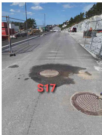
_S17_S16_30062022_012629_017.jpg, 00:00:00, 0.00 Start inspeksjon, 0% / Fra S17. Meterkum, åpen profil
