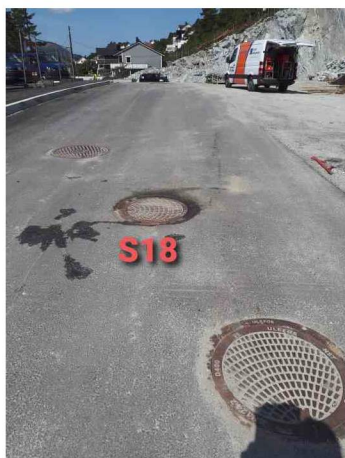
_S19_S18_30062022_015510_015.jpg, 00:00:00, 0.00 Start inspeksjon, 0% / Fra S18. Meterkum, åpen profil
