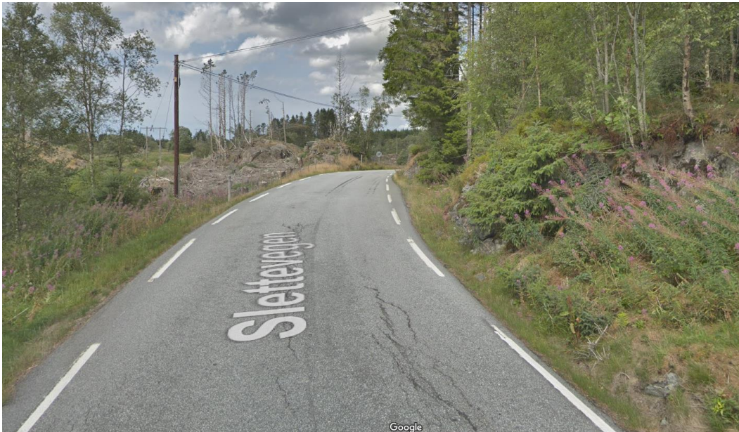
Figur 5-1 Eksisterende veg (Slettevegen) mot nord. På østsiden ses terreng og på vest ses ryddet skog. (Kilde: Google maps 2018)
