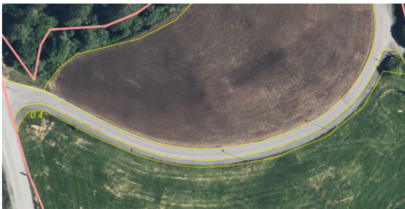
Figur 1 Døme på korleis tilkomstveg er lagt i same nivå som jordbruksarealet på sidene slik at vegen kan brukast til å drifta areala.
