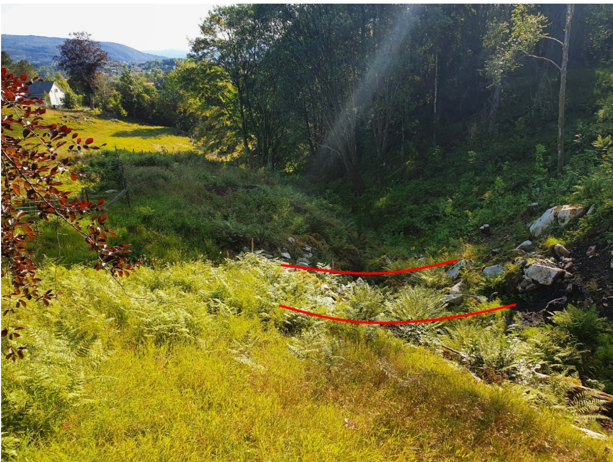
Fig. 2 syner om lag kvar kulverten vert plassert i terrenget. Vi ser og at terrenget nedstraums er slik at vatn vil samle seg i bekkelaupet om det skulle verte utfordringar knytt til kulverten.
