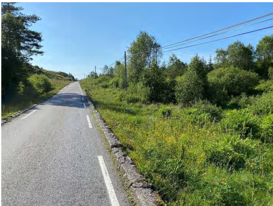
Figur 5: Bilete frå synfaring, veg på steinfylling med betongkant. Bekk/grøft til høgre for veg. Bilete tatt mot søraust.
