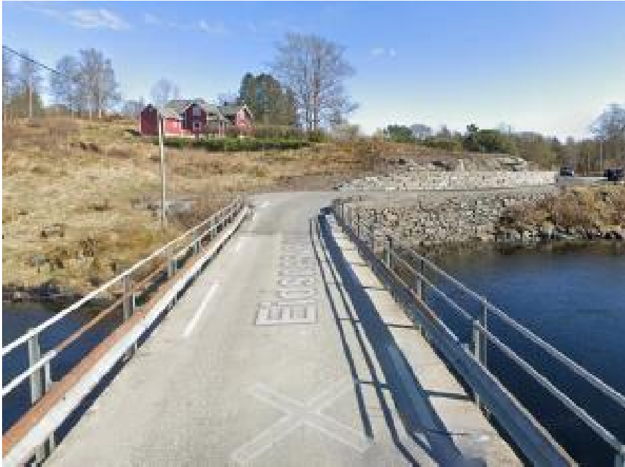
Figur 5 Bilete som viser dagens situasjon frå brua, sett mot aust
