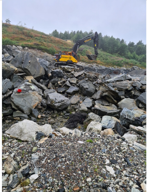
Bilde viser pågående gravearbeid i nærheten av fangdam 1.
