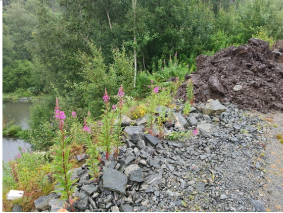
Bilde viser pågående arbeider på Mjåtveit Næringspark. Fangdam 1 kan ses på venstre side. Nylig flyttet/lagret masser vises på høyre side.
