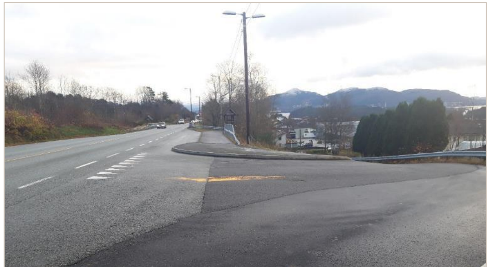
Figur 3-2 Fortau fra bussholdeplass
