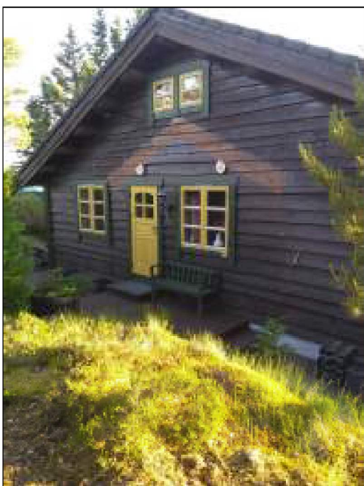
Fig 10 Takoverbygg fasade øst er fjernet
