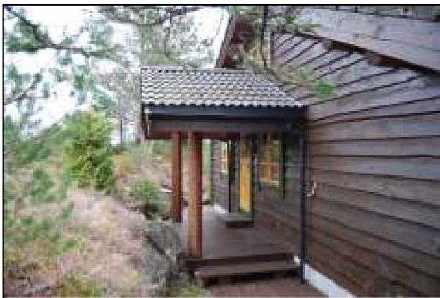
Fig 9 Takoverbygg fasade øst før riving
