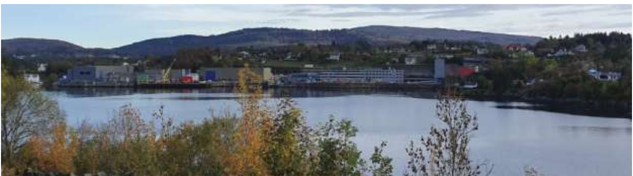
Figur 4-9. Bildet illustrerer opplevelsen av et lukket landskapsrom i sundet der industrianlegget ligger, hvor den visuelle kontakten mellom landsidene er svært god. Ill: Multiconsult
