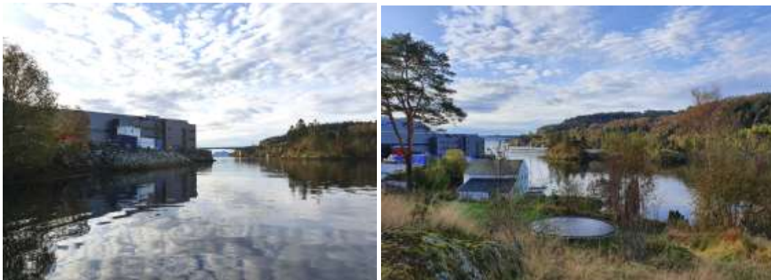
Figur 4-17. Bilder fra vika nord for industrianlegget, som har god sikt mot Krossnessundbrua og landskapet utenfor. Foto: Multiconsult
