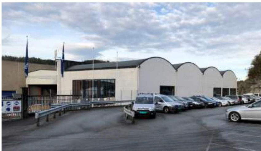
Figur 6-5 Flyhangaren sett mot nordvest.
