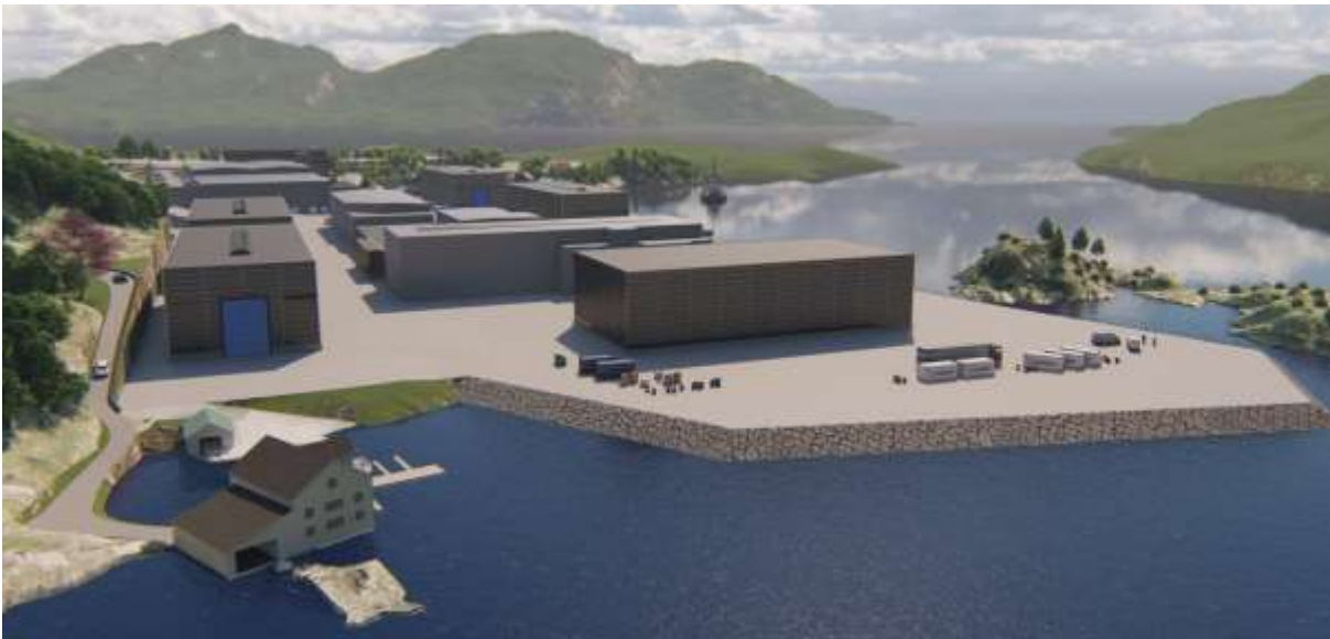
Figur 2-9. Illustrasjonen viser prinsipp for avslutning av fyllingen. Her vist ved planlagt utfylling mot nord og vest, der Gudmundsholmen ligger til høyre i bildet.
