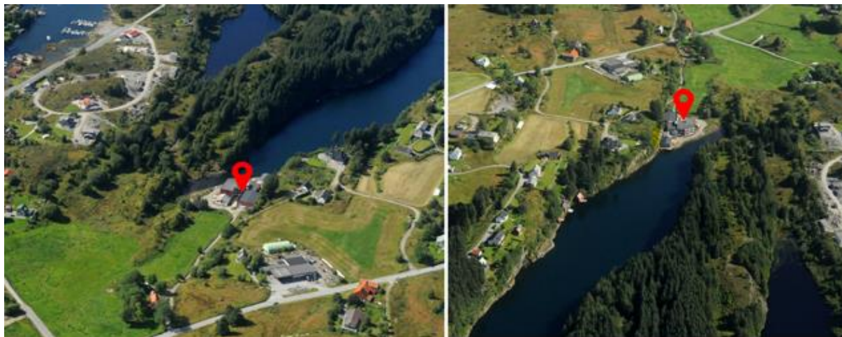
Figur 4: Skråfoto av området, frå 2011. Skråfoto er henta frå nordhordslandskart.no. Foto til venstre er tatt mot vest/nordvest, medan foto til høgre er tatt mot søraust. Næringsbygget på eigedomen gbnr. 427/21 er merka med raud pil.
