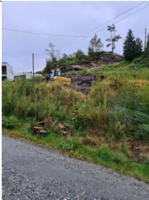
Bilde viser pågående gravearbeid på et mindre område sør for B5. Kloppedalsbekken er lagt i rør under dette området.
