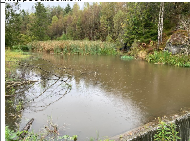
Fangdam 3 (sikringsdam) som skal være sikring i flaumsituasjonar
