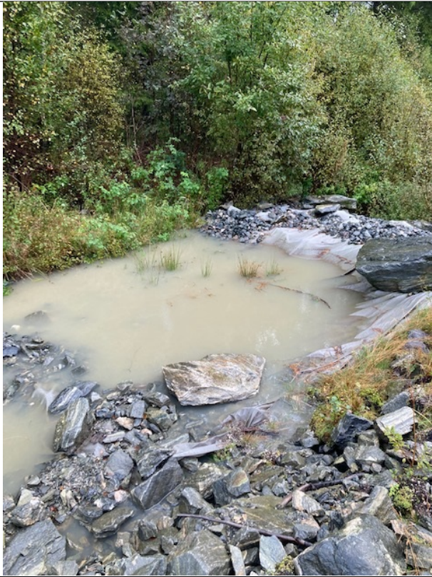
Detta antas å være sedimenteringsbasseng som ble etablert i forbindelse med ulovlighetsoppfølging med mellomlagrede masser.
