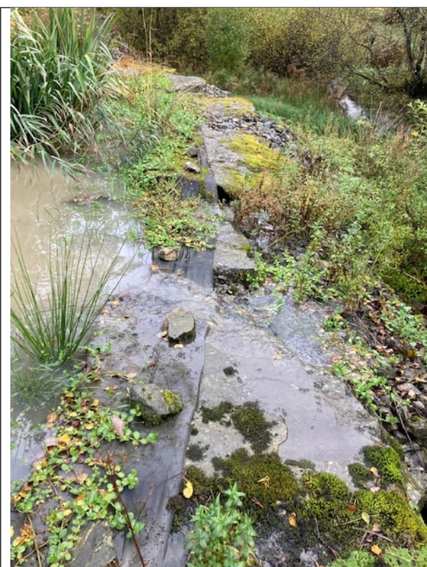
Fangdam 2: Vannet renner nå over dammen og ned i Kloppedalsbekken
