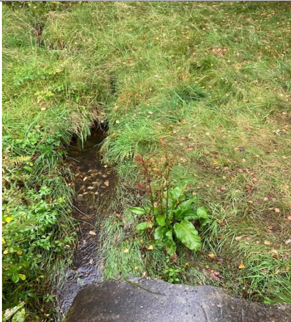
Start tursti Furefjellet nedstrøms sikringsdam. Rimelig klart vann.
