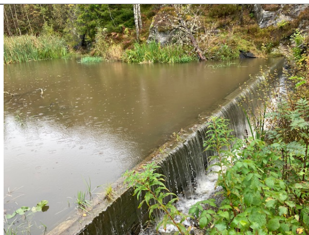
Vann renner over sikringsdam etter mindre enn 1 døgn med nedbør.
