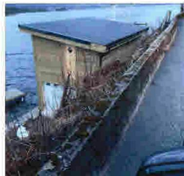
Tidlegare har snøen lagt seg på fjellet mellom naust og veg, samt på naustet sitt tak. Ny situasjon vil føre til at snøen vil legge seg mellom naustevegg og fjellknaus. Vegmynde er uroa for at dette kan påføre tilbygget skader.
