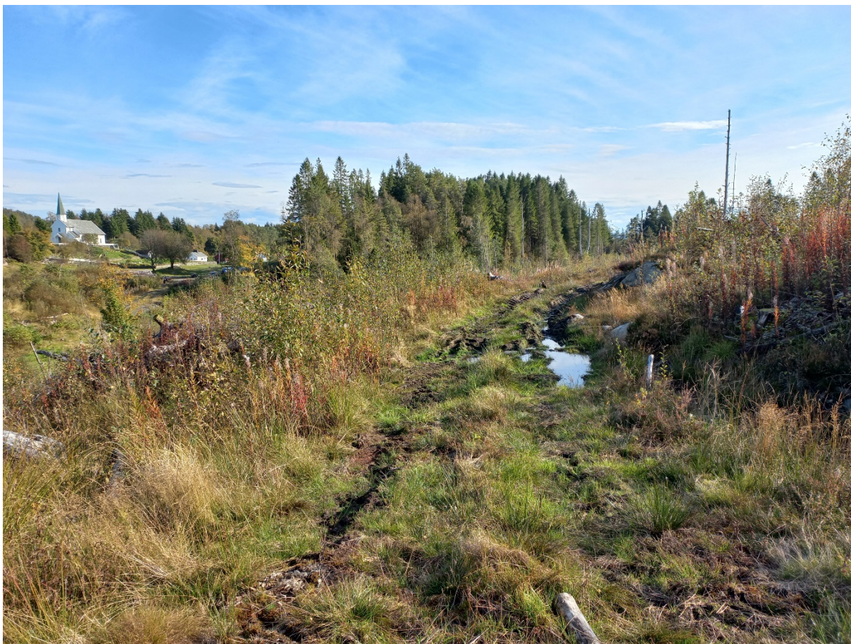
Fig. 1. Der vegen alt er bygd, har den enkel standard og nokre utbetringar krevst mellom anna i høve grøfting.
