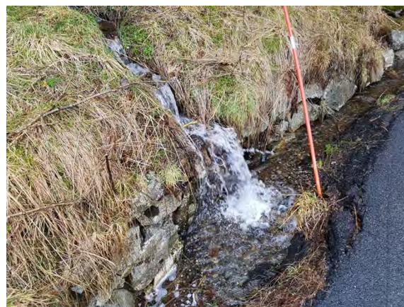
Figur 12: Avrenning sør for planområdet. Det renn mykje vatn langs veggøfta.
