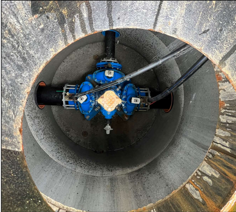
Bilde 1 - Eksisterende brannvannskum SID 44340
