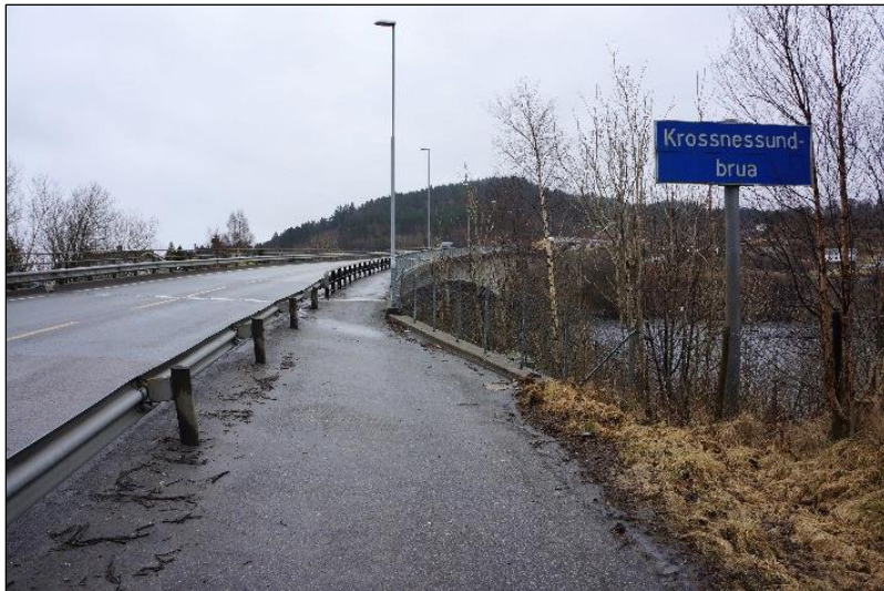
Gang-/sykkelveg i retning mot Holsnøy, over Krossnessundbrua.
