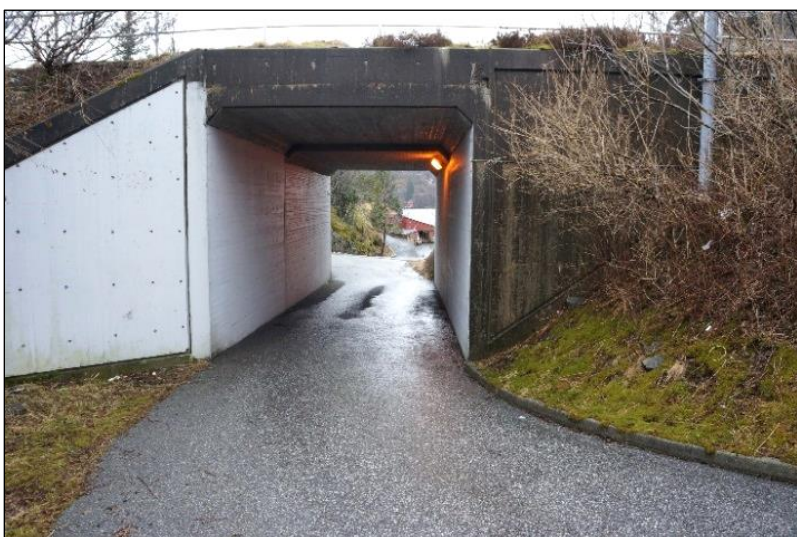
Kulvert nyttast i dag som både g/s-veg og biltilkomst til eigedomar. Høgda er 3,6 meter, høgda bør vere min. 4 meter.
