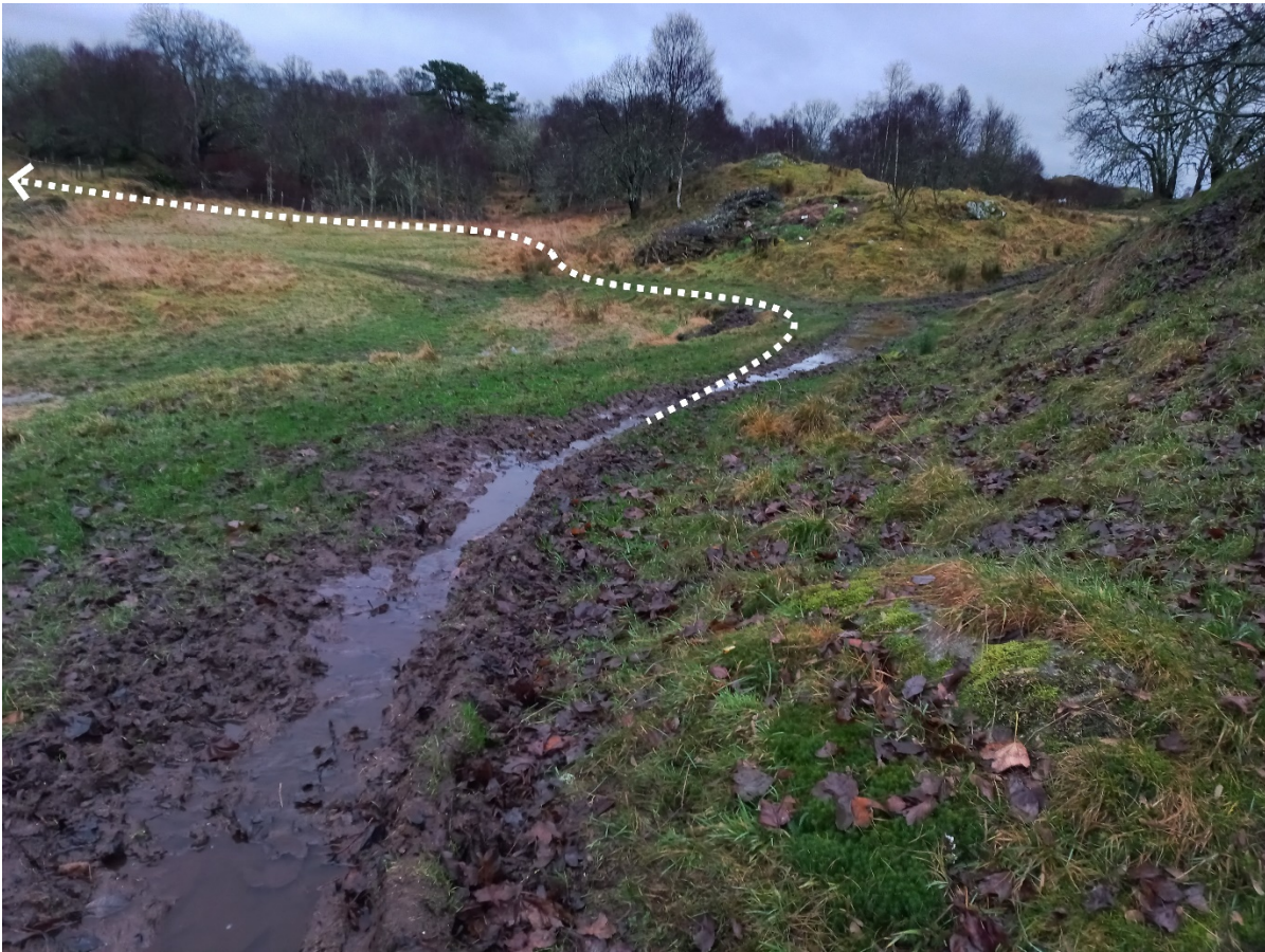
Fig. 2. Veglina skal gå om lag slik pila syner. Ved å leggje traséen i høgre kant av jordet og inn mot gjerdet, sparar ein mykje dyrka jord. Beitet som skal ha tilkomst, ligg bak ryggen til venstre.
