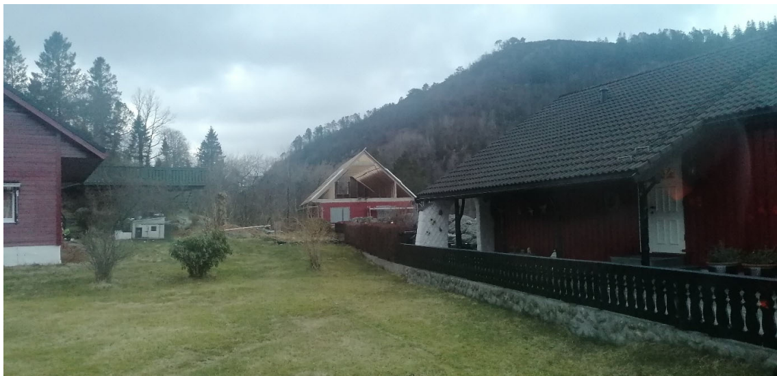
Foto over: Bygg etter montering av nye takstoler.
