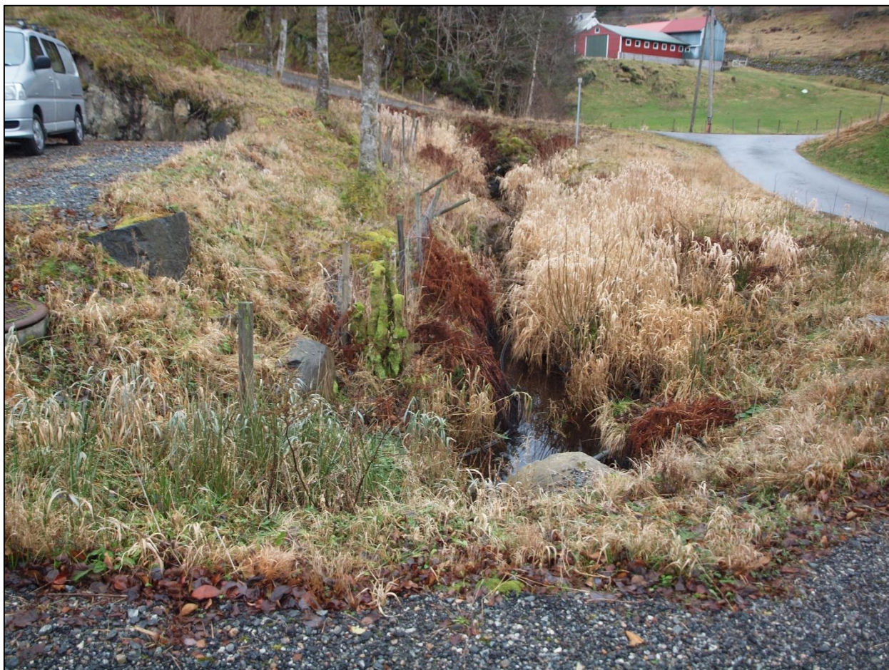
Figur 1-10. Bekken med kantvegetasjon.
