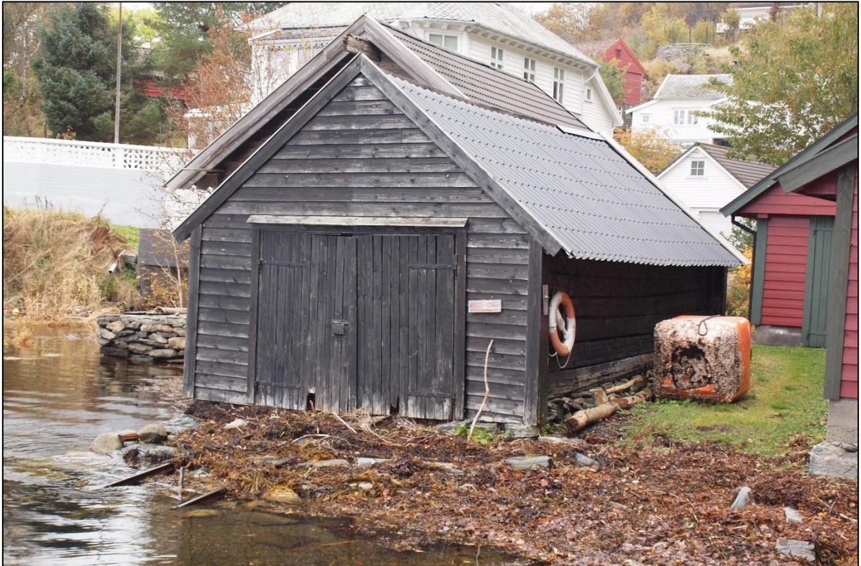
Figur 1-10. Det aktuelle naustet har slitasjespor nederst på kledningen.
