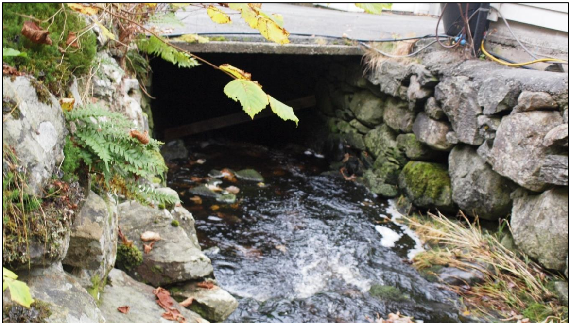
Figur 1-7. Øverste del av «tunnellen» der bekken går under betongdekket.
