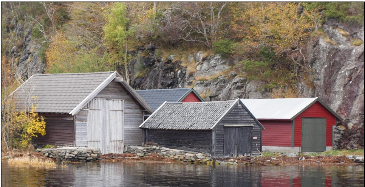
Figur 1-9. Naustene har grunnmur av naturstein.
