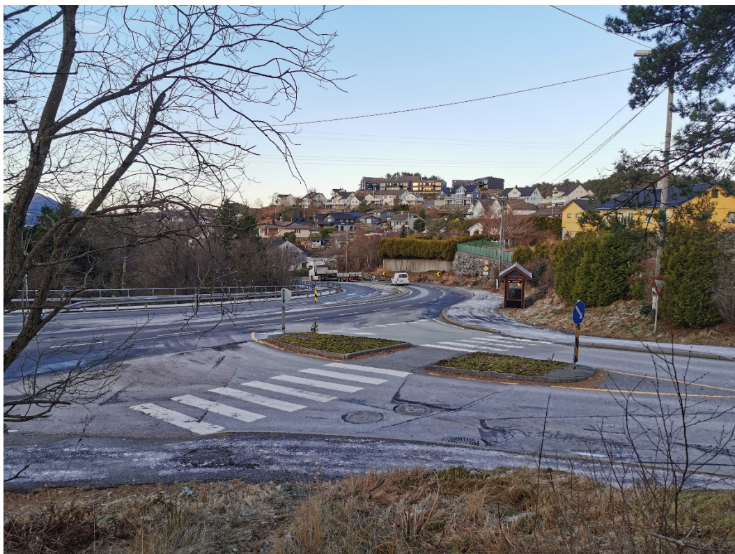
Bilde: Vegkrysset med busslommen som bør flyttes
