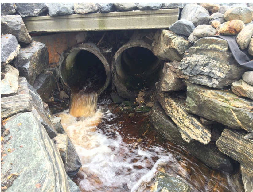
Figur 9. Innløpsbekk nord til Tjukketvatnet fotografert i ein periode med fuktig vêr i oktober. Biletet er teken frå same ståsted som Figur 8, men tatt i mostatt retning. Legg merke til at nivåforskjell mellom kulvert og bekk hindrar fri fiskevandring. Foto: Uni Research (G. Velle).
