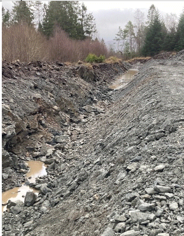
Nyetablert drenerings- og avskjæringsgrøft på gbnr 322/281
