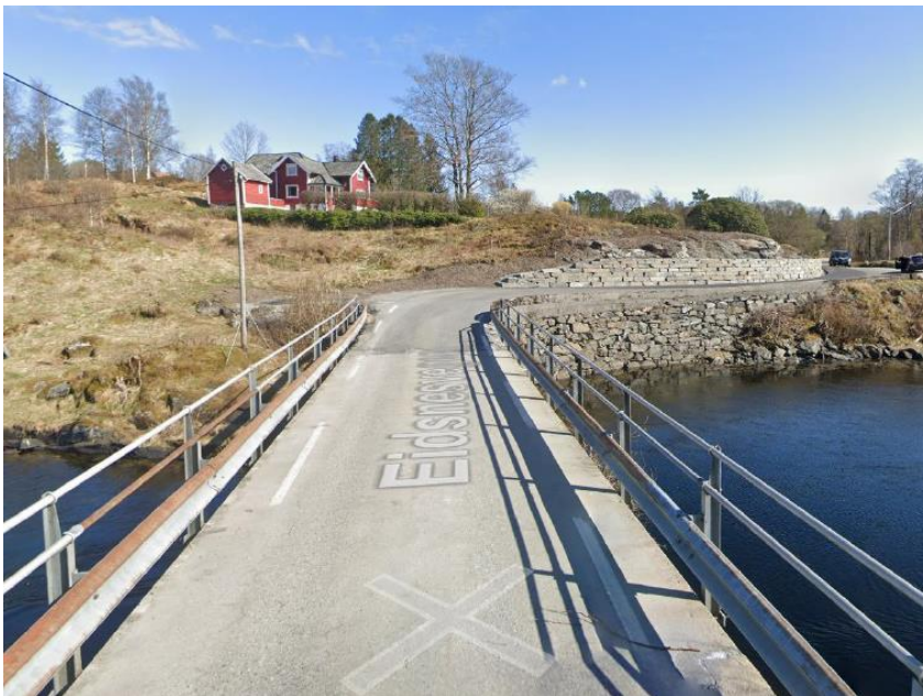
Figur 36 Eidsnesvegen etter at knaus er fjerna
