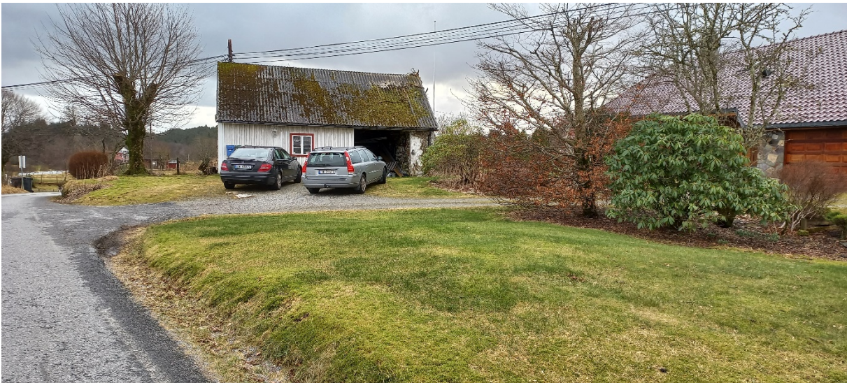
Fig. 3. Uthuset som skal leggjast til tomta til bustadhuset på bnr. 42 som vi ser til høgre. Veggen til driftsbygningen på bnr. 1 tek av frå Kvalvågnesvegen nett batt der biletet er teke. Sjå fig. 4.
