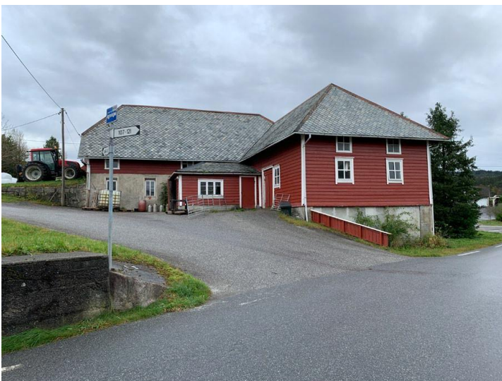
Figur 25 Busstopp utanfor Eidsnesvegen 107.
