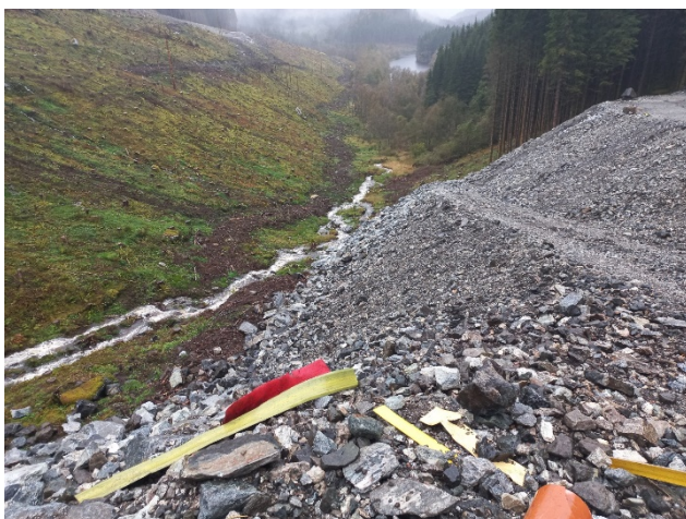
Fig. 1. Vi ser eksempel på framandelement som er sortert ut og skal køyrast bort.
