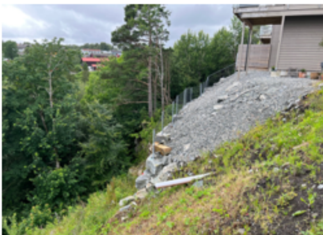
Skråning mellom gbnr. 323/622 og 623.
