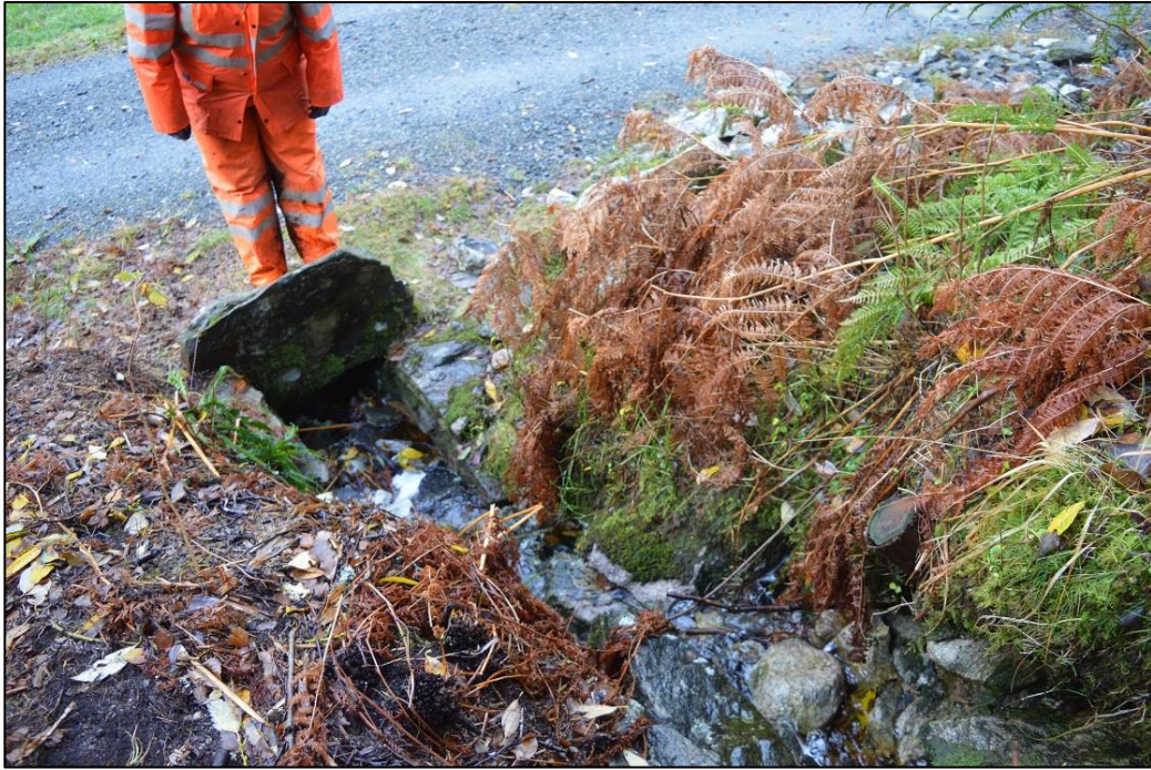
Figur 26: Stikkveit som går under grusveg vest for dyrka mark og truleg ned til samleveil, foto teke mot aust-søraust
