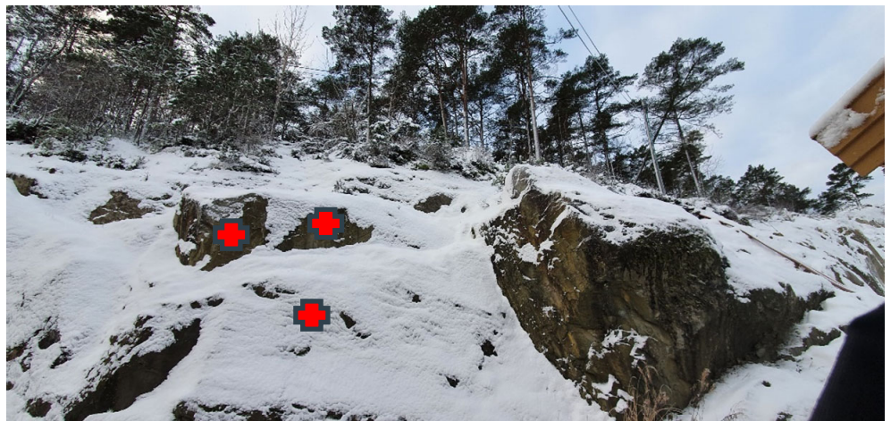
Figur 12 Anbefalt bolting blokk 1.
