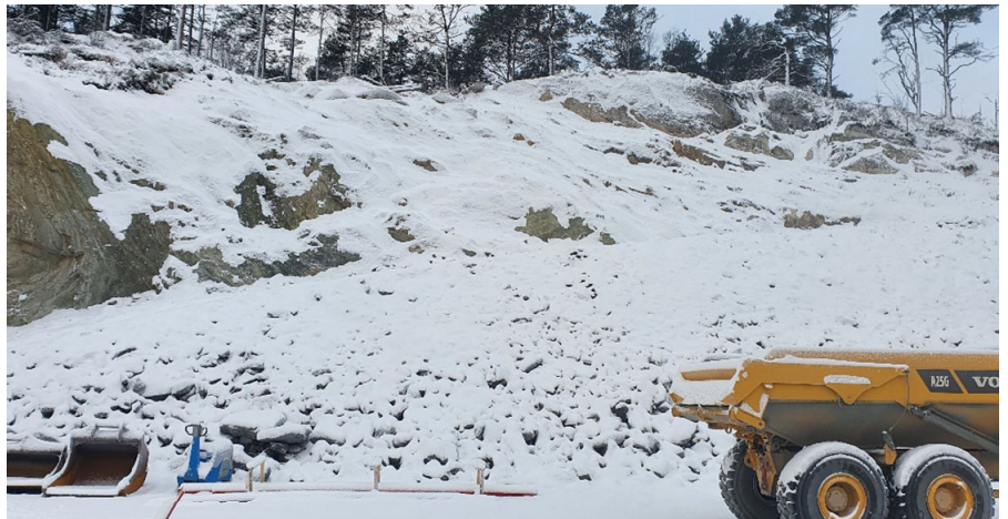
Figur 9 Nederste del av skjæringen er dekket av anleggsvei.
