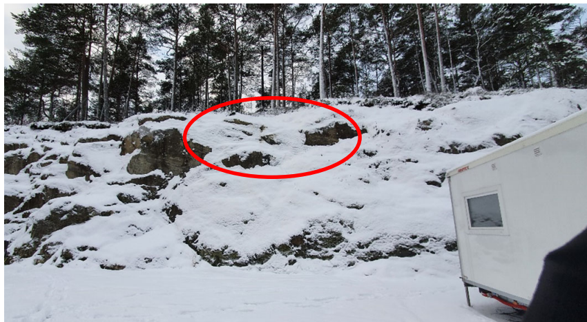
Figur 2 Vann i topp skjæring mellom parkeringsplass og kontorbrakker.
