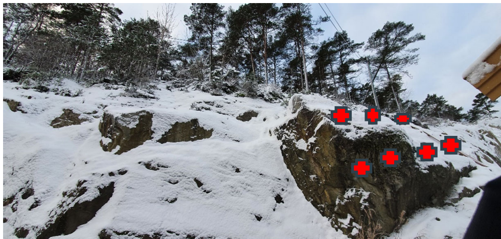
Figur 13 Anbefalt bolting blokk 2.
