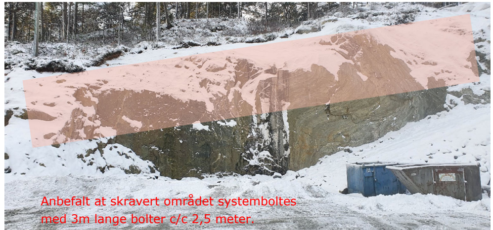
Figur 14 Anbefalt område med systembolting bak nybygg.
