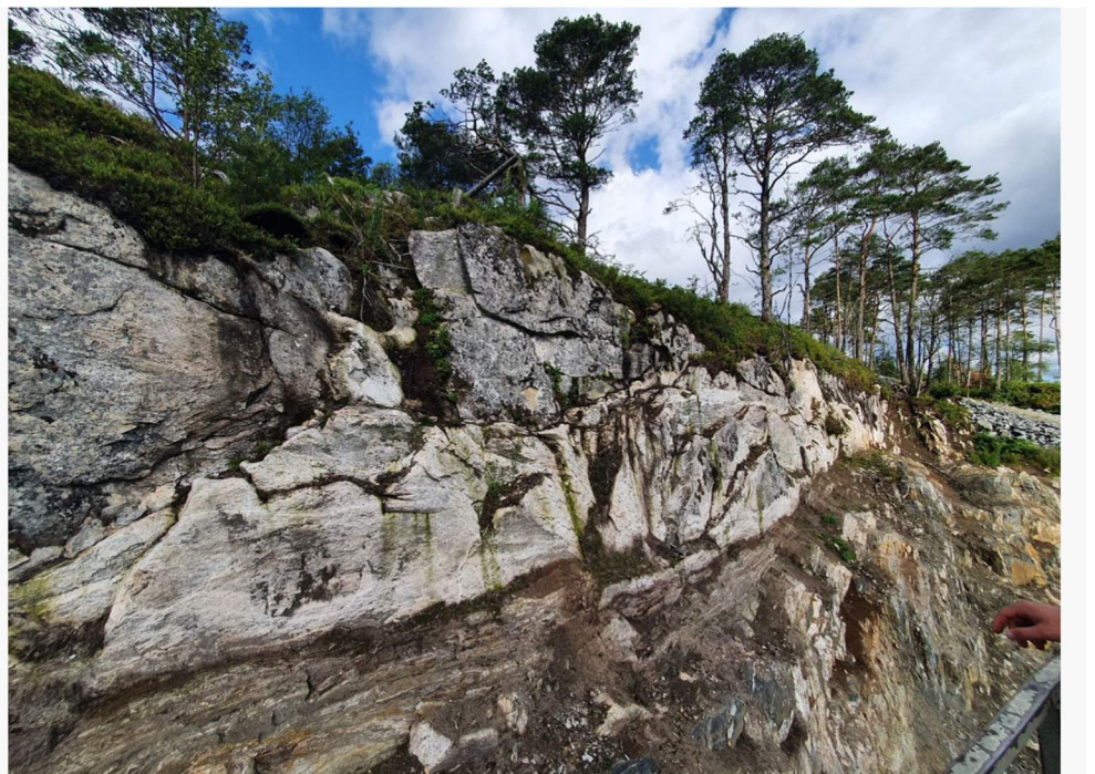
Figur 3: Bilde fra befaring i juni, tatt mot NV.
