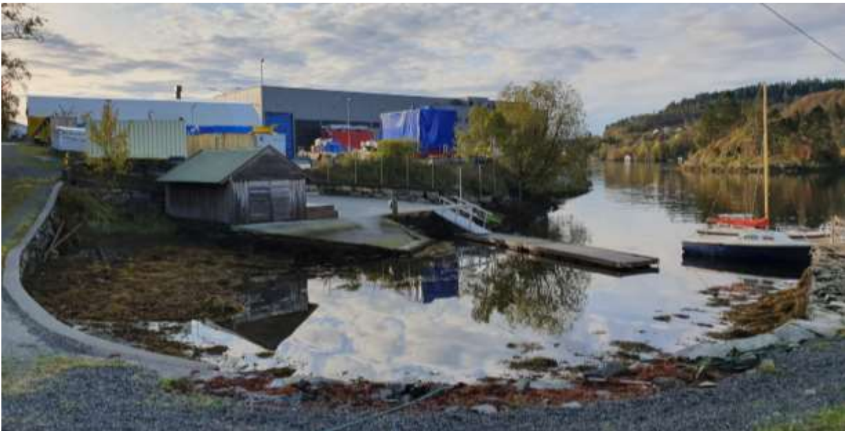
Figur 5-1: Havn brukt av Nordhordland padleklubb nordvest for industriområdet til Framo AS på Flatøy. Foto: Multiconsult.
