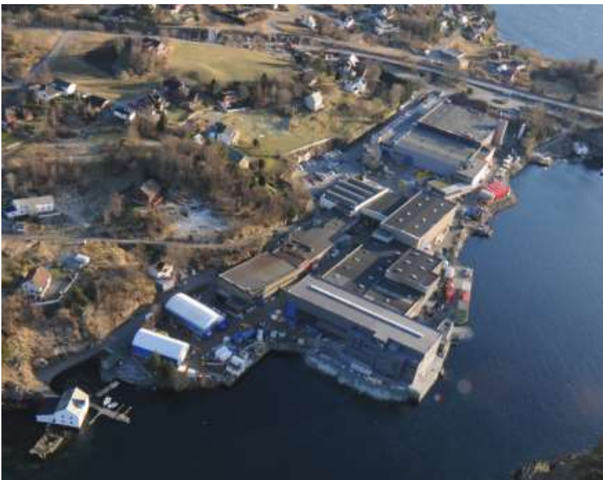
Figur 2-1. Dagens situasjon. Bakenforliggende boligområde og småbåthavn har tilkomst både via næringsområdet og fra nord. Foto: Multiconsult
