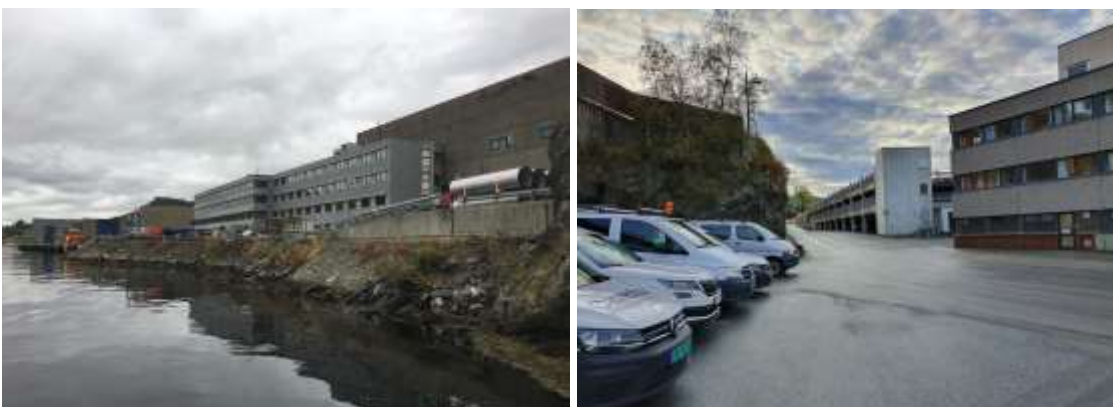
Figur 4-13. Bilder av industrianlegget sett fra nabobebyggelse langs sjøen og parkeringsareal. Foto: Multiconsult
