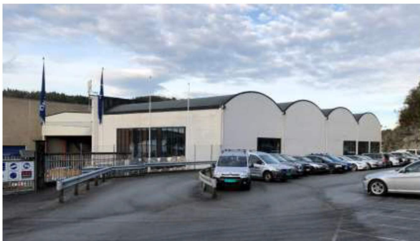
Figur 6-5 Flyhangaren sett mot nordvest.
