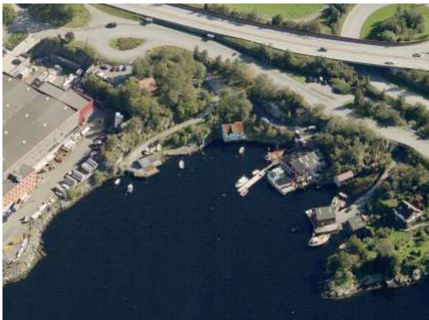
Figur 6-10 Flatøy kai sett mot sørøst
