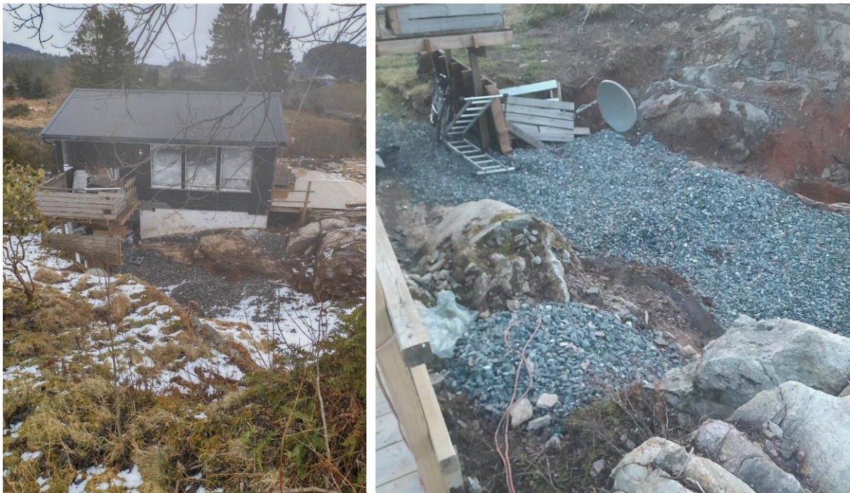
Figur 2. Venstre: Foto som viser eksisterende fritidsbolig og påbegynt vedlikeholdsarbeid. Høyre: Nærbilde av grunnen inntil boligen der det planlegges tilbygg. Nærmest boligen er det en del bart fjell og det er lagt ut litt pukk/grus. Lenger ut fra boligen er det jorddekke med lavvokst vegetasjon. Foto: Ruben Fureli.
