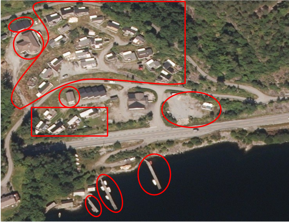
Figur 6: Viser ulovlege tiltak på eigdommen. Kjelde: Alver kommune, Pålegg om retting og vedtak om tvangsmulkt.
