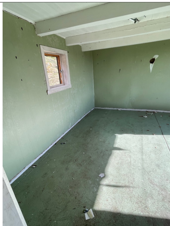
Stue sør – sett mot sørøst
