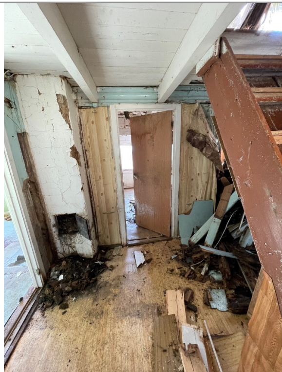
Gang – sett fra inngangsdør
