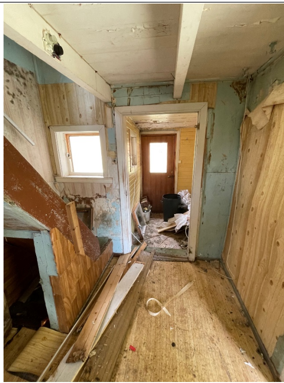
Gang – sett mot inngangsdør
