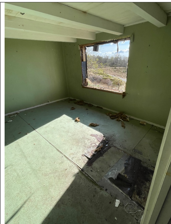
Stue sør – sett mot sørvest
