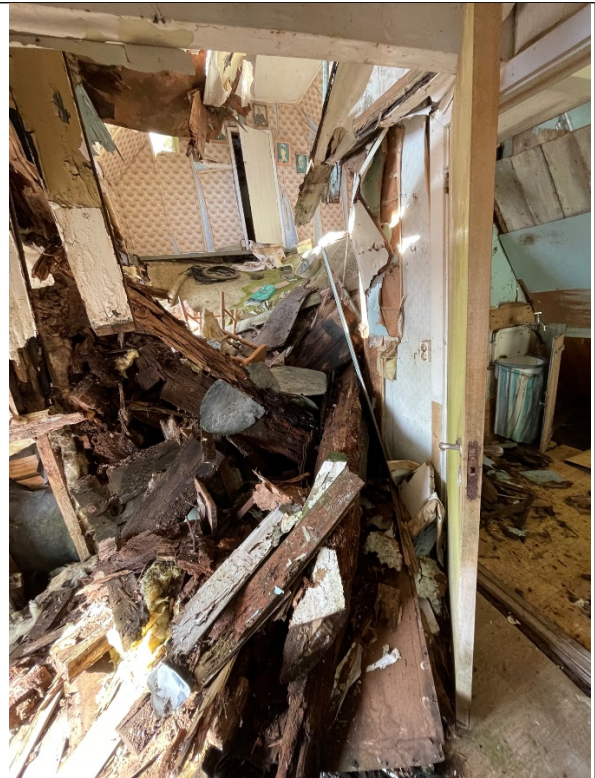
Kjøkken – sett mot stue nord, og dels ut dør mot gang i høyre bildekant. (Vegg fra kjøkken mot stue nord er råtnet ned og mangler, og tapetvegg i bakkant på foto er vegg i etasjen over – på loftet – fordi loftsgulvet er falt ned i etasjen under).
