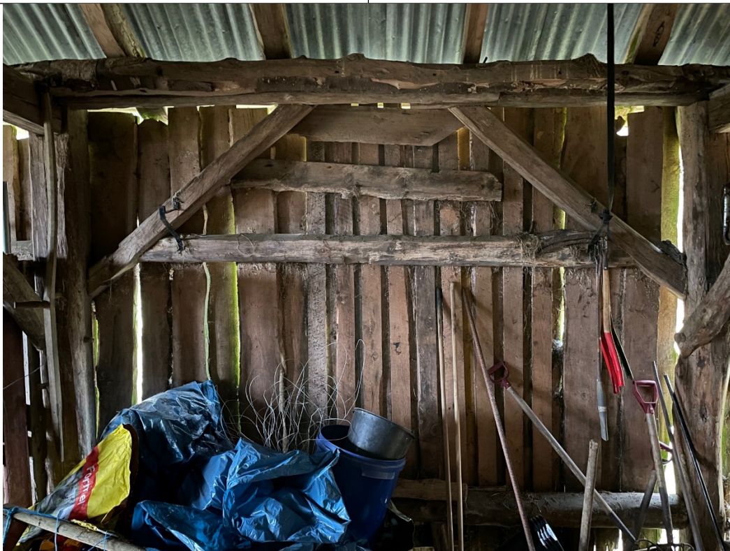
Vegg mellom sentersøyle og dørsøyle venstre side
