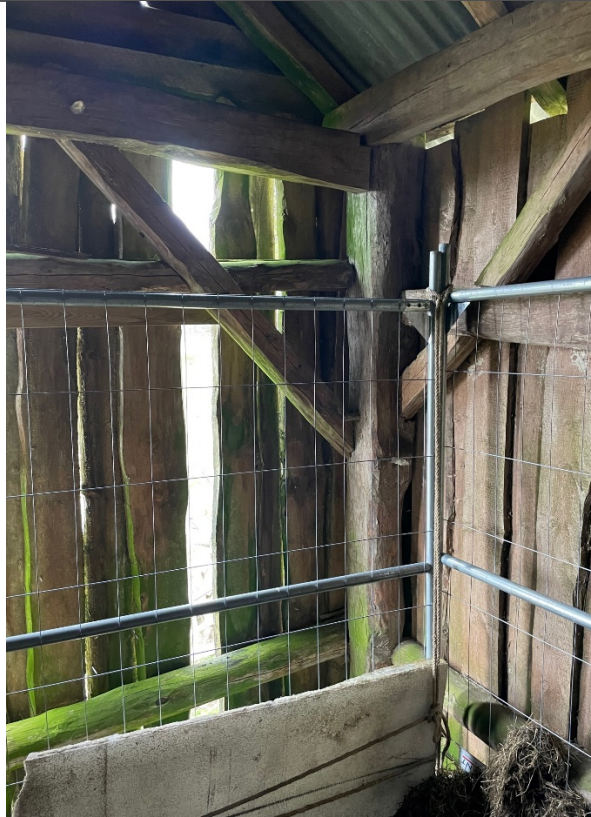
Grindverk – søyle nordøst
