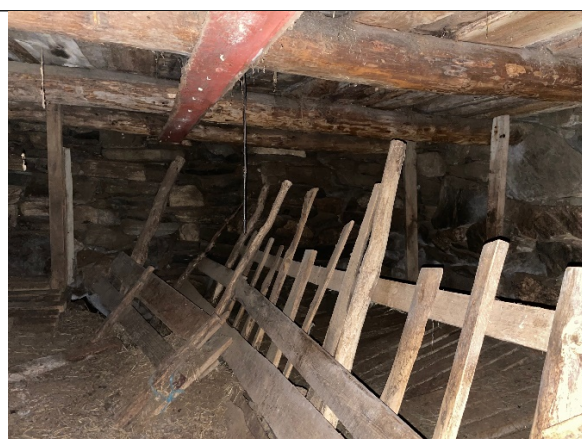
Steinløe – underetasje mot sørvest
