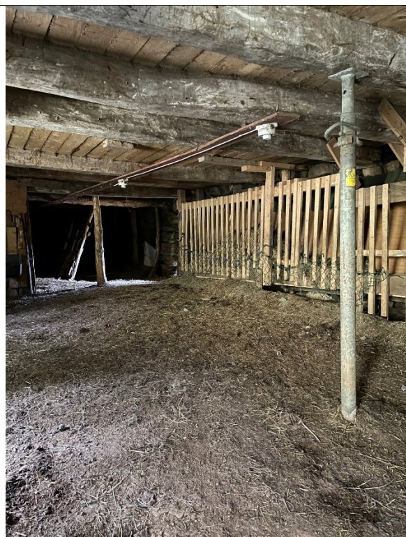
Steinløe – underetasje vestveggen
