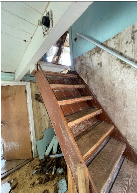
Gang – sett mot loftstrapp
