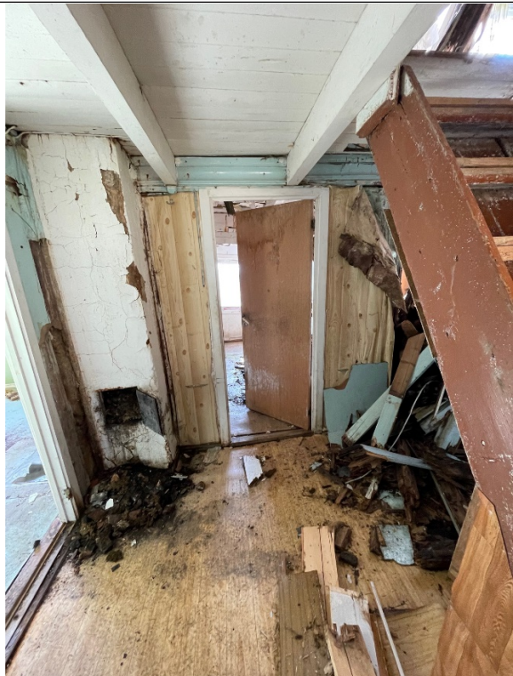
Gang – sett fra inngangsdør
