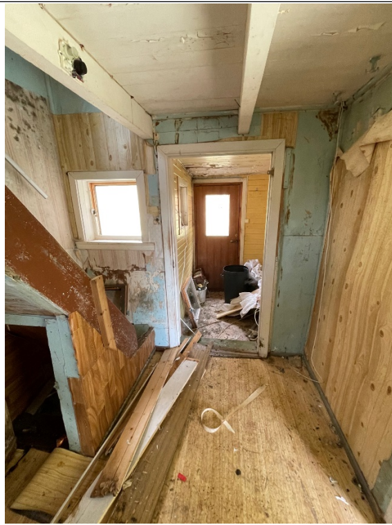
Gang – sett mot inngangsdør
