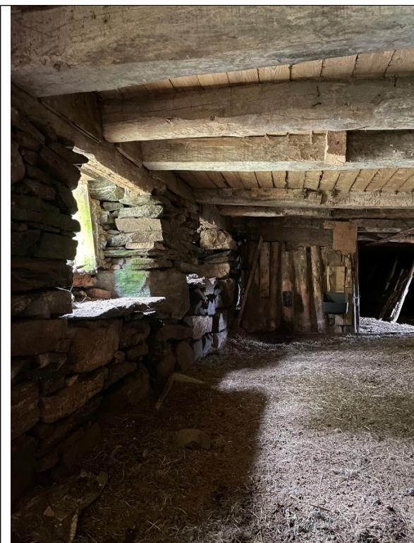
Steinløe – underetasje østveggen
